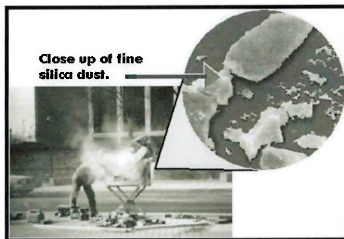
Figura 9- Partículas de sílica livre cristalina contida na poeira gerada no ambiente de trabalho.
